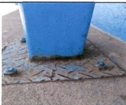
Foto 5: Sustrucción de estructura
