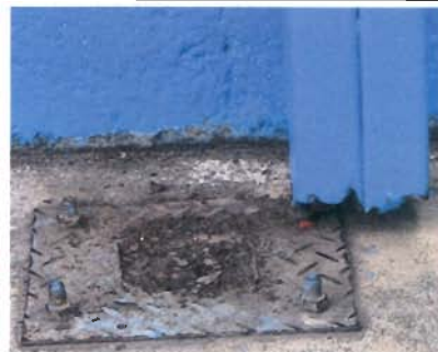
Foto 6: Sustrucción de estructura .
